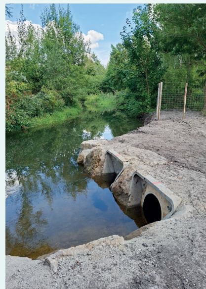
Des réseaux d'assainissement renouvelés.
