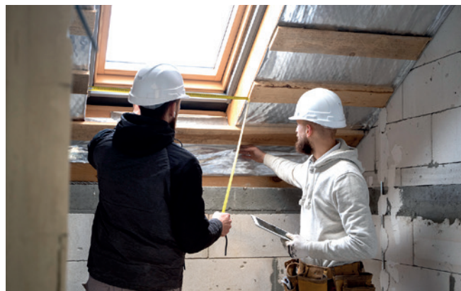
La CCSSO accompagne la réhabilitation de logements.
