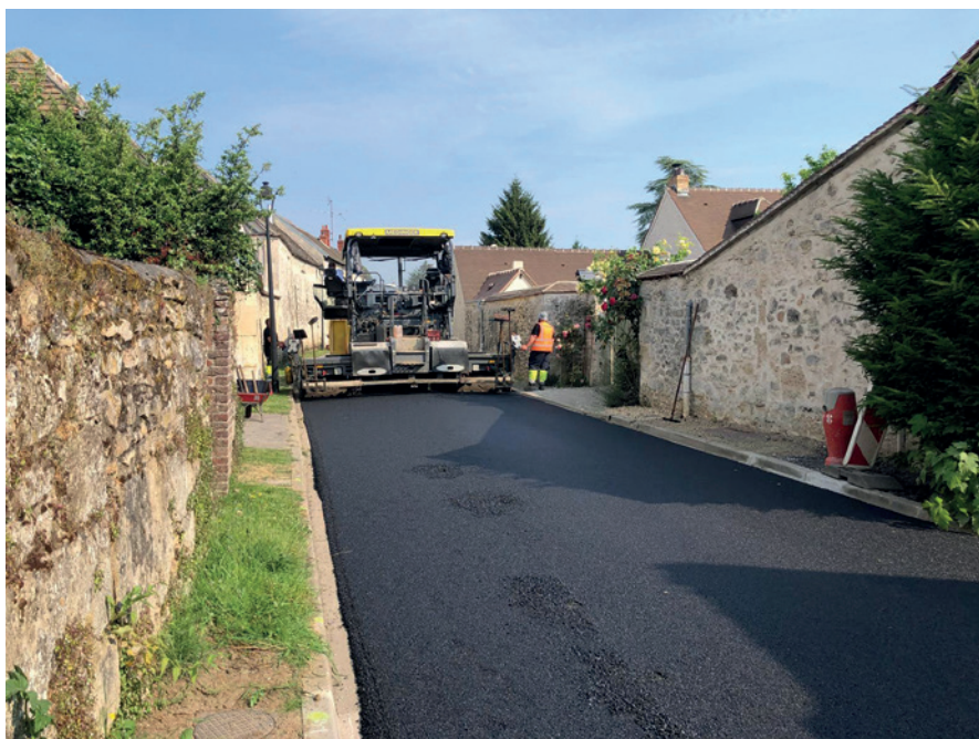
Réfection de la chaussée rue vieille de Pont à Villers-Saint-Frambourg-Ognon.
